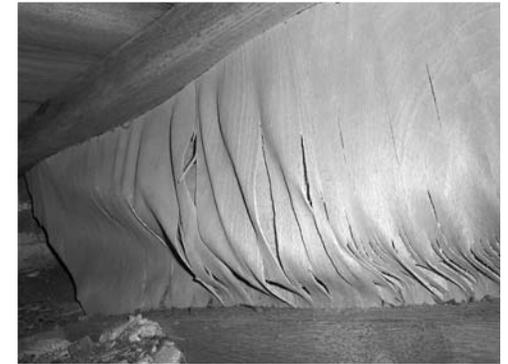
Auflager der Dachkonstruktion – Die gesamte Last des Daches quetscht den geschwächten Sperrholzsteg zusammen
