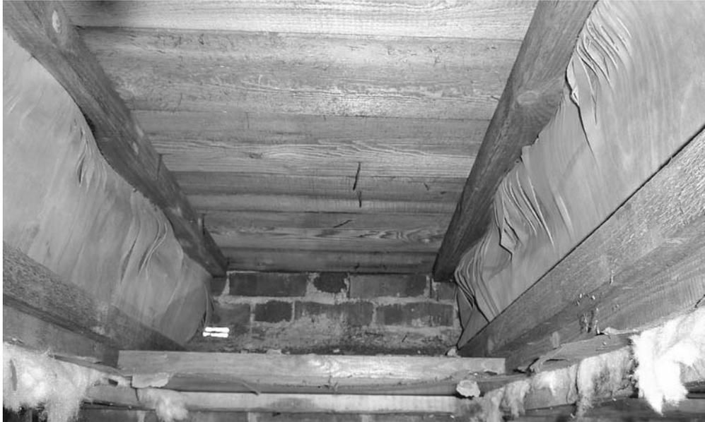
Tragende Sperrholzträger mit deutlich sichtbaren Auflösungserscheinungen, Rissen und Verformungen
